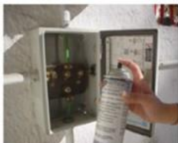
* Área de cobre a proteger con Antiox
